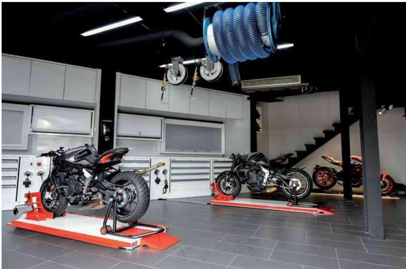
“PROGETTAZIONE E INSTALLAZIONE IMPIANTISTICA ASPIRAZIONE GAS DI SCARICO”
